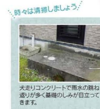
犬走りコンクリートで雨水の跳ね返りが多く基礎のしみが目立ってきます。
