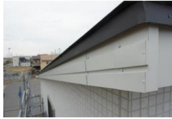
鋼板破風、垂直軒先仕上げ
