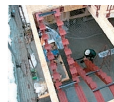
④鉄骨階段工事 一発施工の鉄骨階段軸
