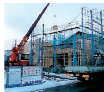
③フレーミング 構造躯体はもちろん2×4構造 年も明けて天候も崩れ出し...
