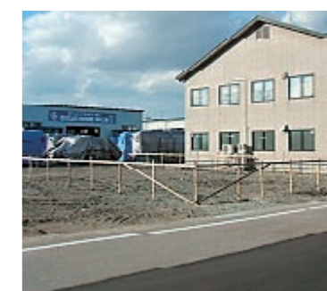
①着工 秋晴れの中、工事着手
