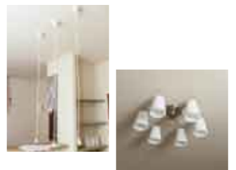
43 設備取り付け(照明)
