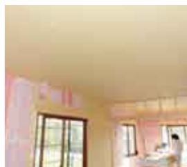
32 内部造作 ①ラスターボード張り ②雨どい施工
