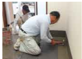
46 玄関ポーチ仕上げ
