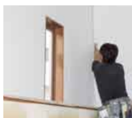
34 ドライウォール 1.5x3 壁・天井を一体化する ドライウォール工法を 採用
