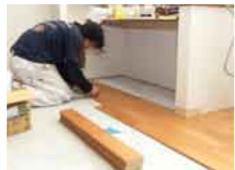
45 フローリング施工
