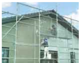
23 壁吹付け仕上塗装 24 壁下地塗り施工
