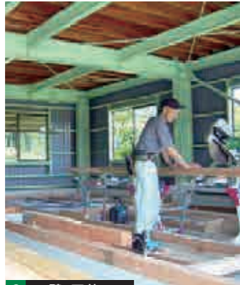
2 壁、天井へ 材料の搬入他移設材の仕分け。
