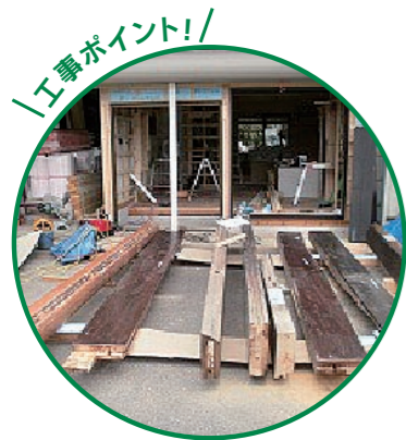
お客様の御生家の思い出の材料を丁寧に解体。
