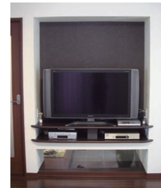
◀テレビを置くために壁をふかし、カウンターを取り付け。下の部分はガラスになっており、玄関が少し見えるようになっています。①
