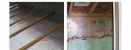
▲屋根下地に断熱材、壁に断熱材を施工
