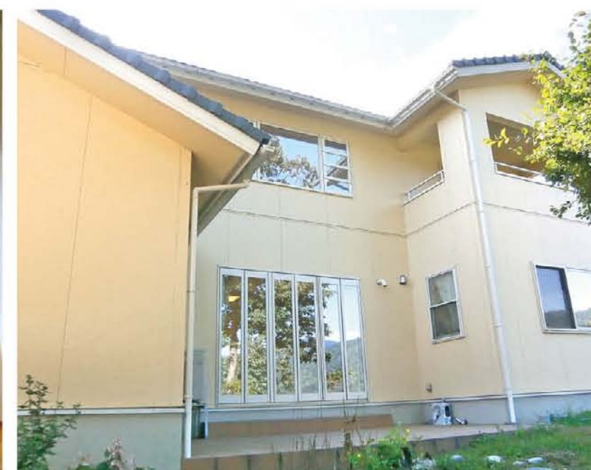
外から見たリビングとテラス側。たくさんの窓から自然光がたっぷり入り込みます。
