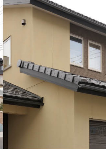
▲吹付け塗装仕上げのおちついた外壁
