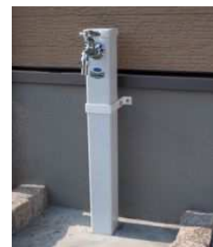
■外部立水栓+加圧リング 横水栓
