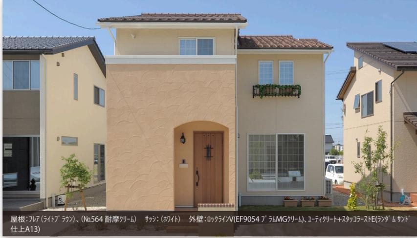
屋根:ルーフ(ライトブラウン)、(No.564 耐摩クリーム) サツ: (ホワイト) 外壁:ロッキングV(EF9054 プラムMGクリーム)、1-ティグレート+スタッコラーストE(ランダムサツ仕上A13)
