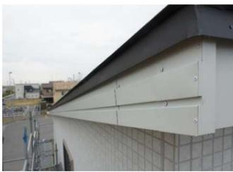
鋼板破風、垂直軒先仕上げ
