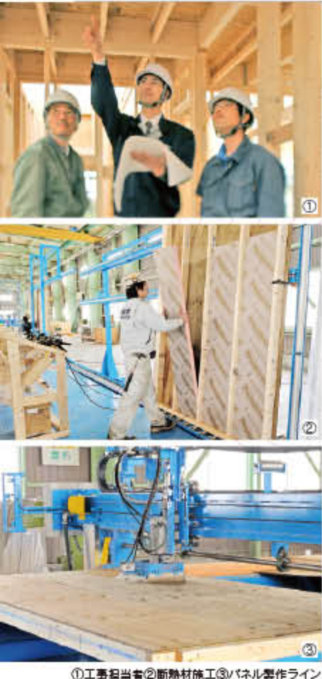
①工事担当者 ②断熱材施工 ③パネル製作ライン
