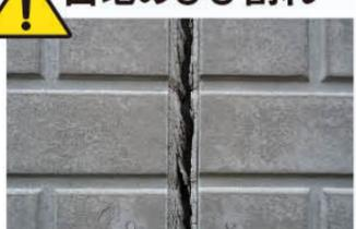
乾燥伸縮によりひび割れ。雨水の浸入の恐れあり。
