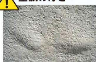
経年劣化により発生し、漏水の原因。
