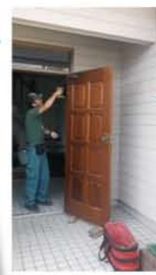
まずは木製玄関ドアの 撤去作業からスタート
