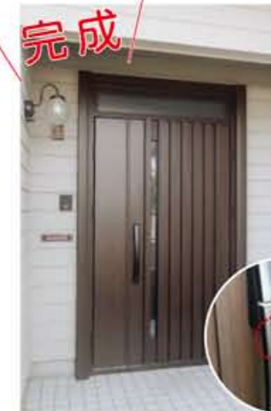
既存の「枠材」はそのままに、上からカバーするように新しいアルミ枠を施工。 外壁を壊すことなく1日で見違えるように玄関ドアが変わります。
