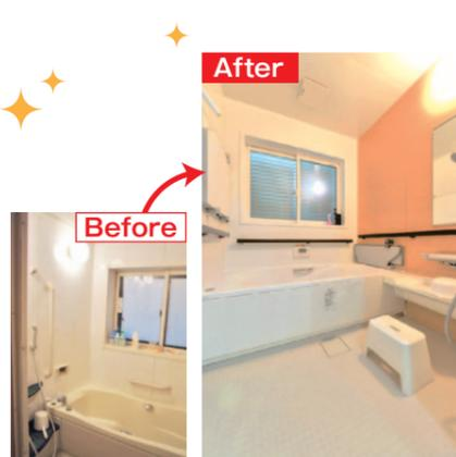
水廻りの床は全てフラットにして手すりを取付。帰宅した際、玄関からトイレ、洗面所まで車いすで直線的に移動できるようにしました。
