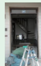
既存の「枠材」はそのままに、上からカバーするように新しいアルミ枠を施工。外壁を壊すことなく1日で見違えるように玄関ドアが変わります。
